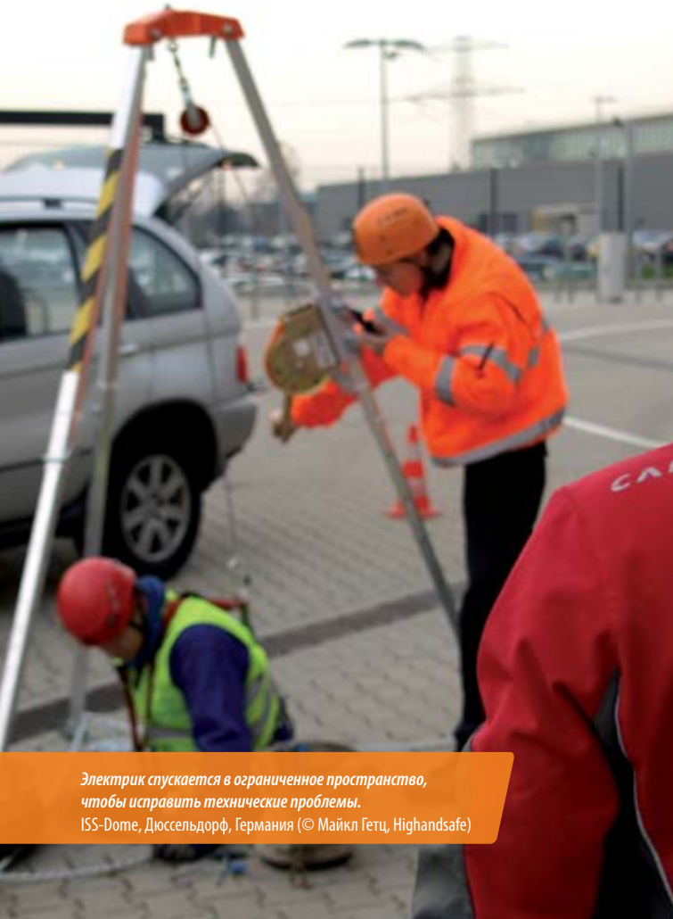
Рис. 8 Одна из возможностей доступа в ограниченное пространство происходит при помощи использования трипода (или монопода с фиксированной/поворотной лебедкой) в сочетании со спусковым и подъемным устройством, чтобы в случае аварии работник мог быстро исправить ситуацию. В любом случае выше перечисленное оборудование необходимо использовать совместно с системой остановки падения. Если работа должна производиться на большой глубине и не представляется возможным использовать для спуска/подъема устройство с металлическим тросом (из-за нехватки длины), спуском/подъемом можно осуществлять с помощью системы, оснащенной канатом.
