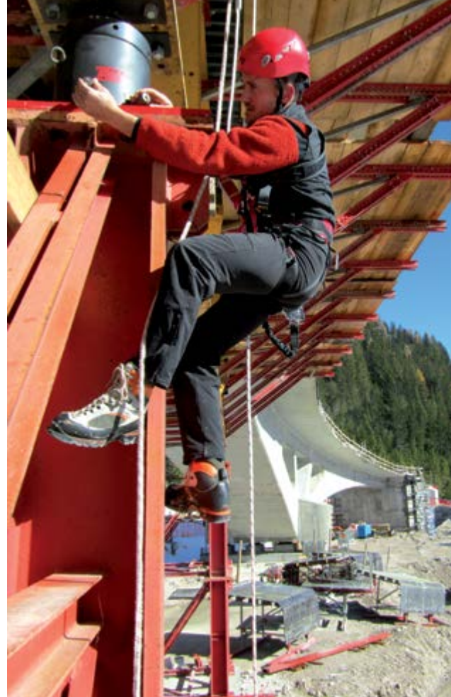
Рис. 17 Cobra 2 является инерционным страховочным устройством и сертифицировано по EN 360 так же для использования в рабочих условиях с фактором падения 2. Cobra 2 во время падения втягивает строп обратно во внутрь механизма значительно уменьшая тем самым высоту свободного падения и, следовательно, необходимого свободного вертикального пространства ( рис. 17а ).
