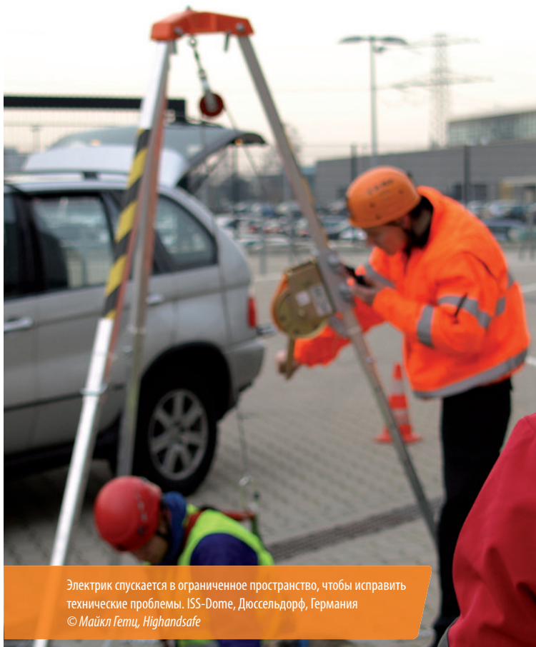
Рис. 13 Одним из вариантов доступа в ограниченные пространства является использование трипода в комплекте с лебедкой, которая позволит быстро извлечь работника в случае экстренной ситуации. Эти операции всегда необходимо проводить с использованием дополнительной страховочной линии.
