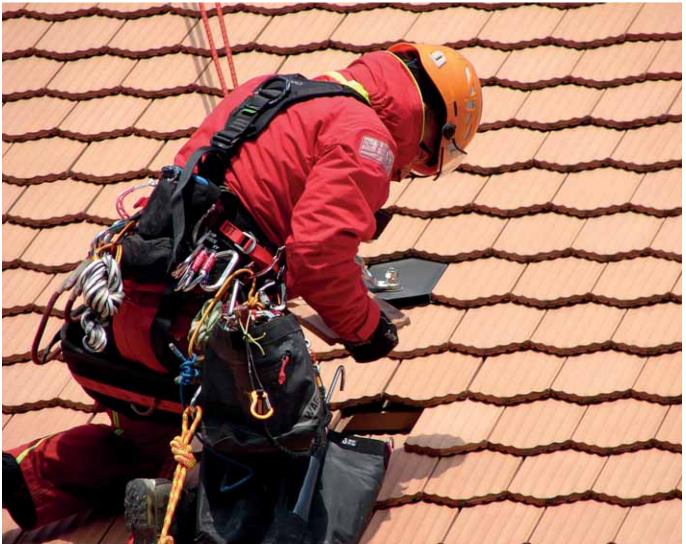
Work on the roof of the parliament of the canton of Vaud. Trabajos en el tejado del Parlamento del cantón de Vaud. Lausanne, Switzerland (courtesy of Corde-Access SA, rigger Andrea Giazzi, ph. Corde-Access SA).
