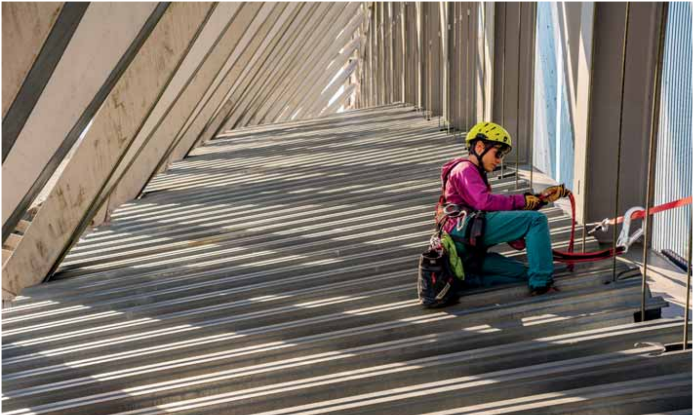
Philippa Betts during inspection operations at the famous Holmenkollen ski-jump structure. Philippa Betts durante las tareas de inspección de la famosa estructura para el salto de esquí de Holmenkollen. Oslo, Norway (courtesy of Varri AS, ph.Kyrre Buxrud).
