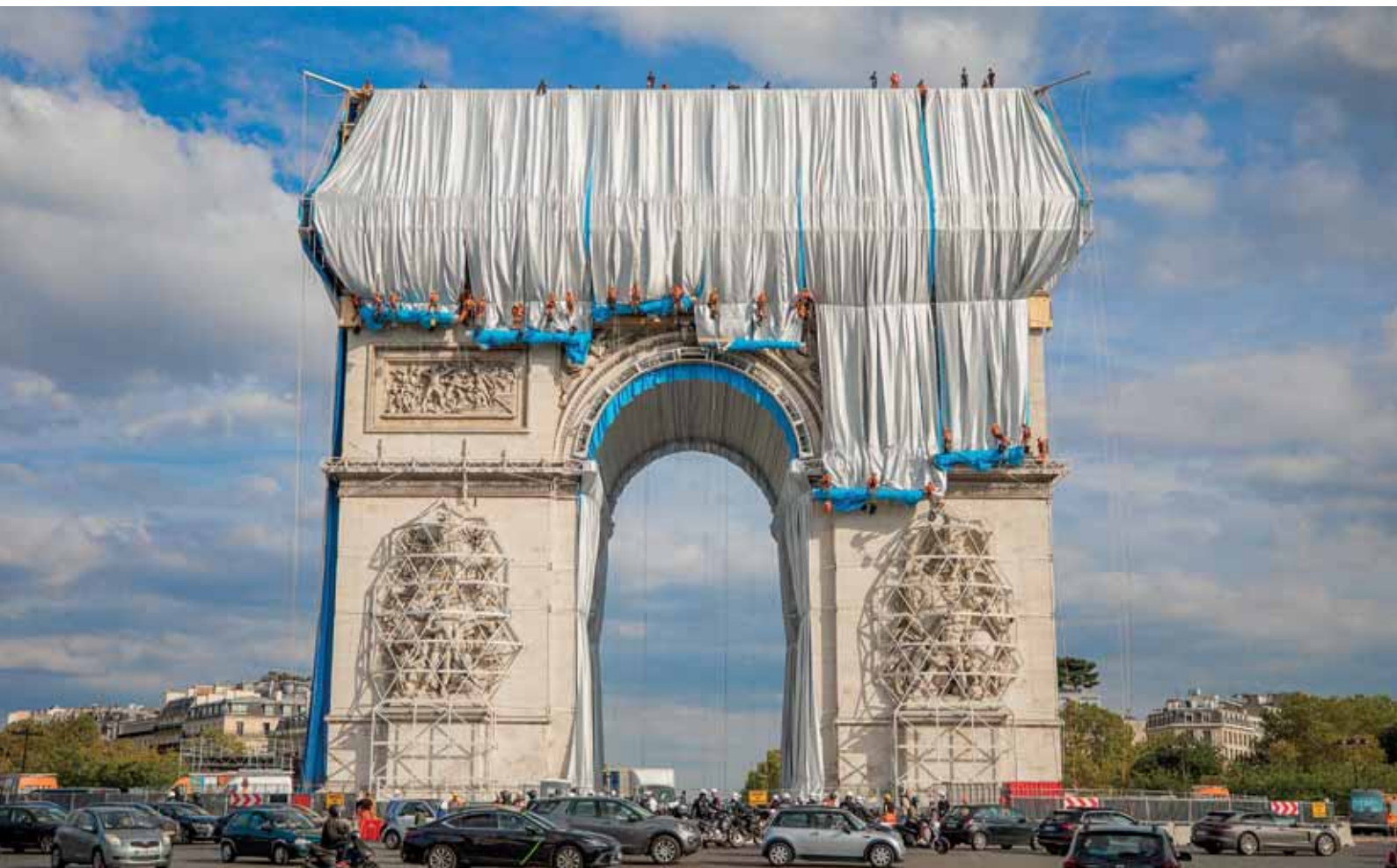
Jade professionals at work on Christo's latest work: the wrapped Arc de Triomphe. Profesionales de Jade trabajando en la última obra de Christo: el Arco del Triunfo empaquetado. Paris, France (courtesy of Jade, ph. Daniel Lengart).
