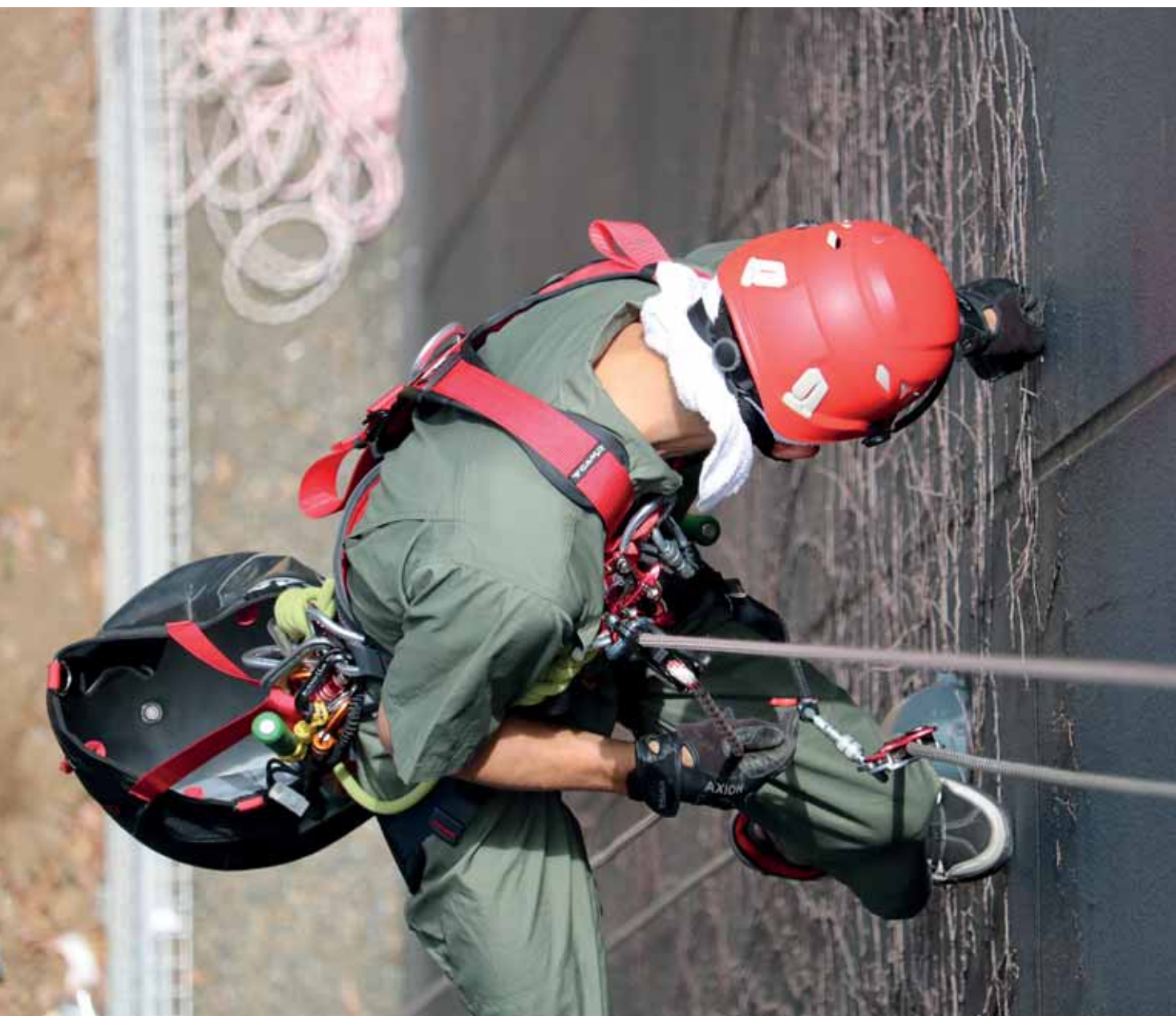
Taizo Fukunaga doing rope access maintenance on the Caravan headquarters. Taizo Fukunaga realiza operaciones de mantenimiento con cuerdas en las instalaciones de Caravan. Tokyo, Japan (courtesy of Caravan Co. Ltd., ph. Ryuichi Ihara).
