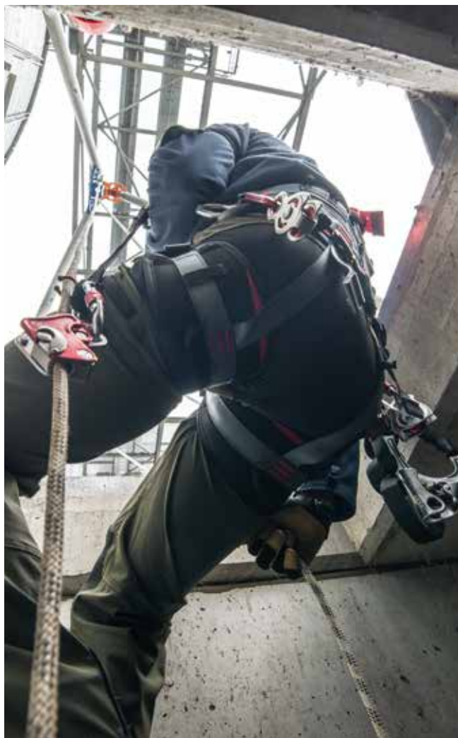
Inspection on transport systems at Voergroep Zuid, producer of animal feed. Inspección de los sistemas de transporte en Voergroep Zuid, productores de pienso para animales. Oss, The Netherlands (ph. Riky Felderer, courtesy of Unispect, © C.A.M.P.).
