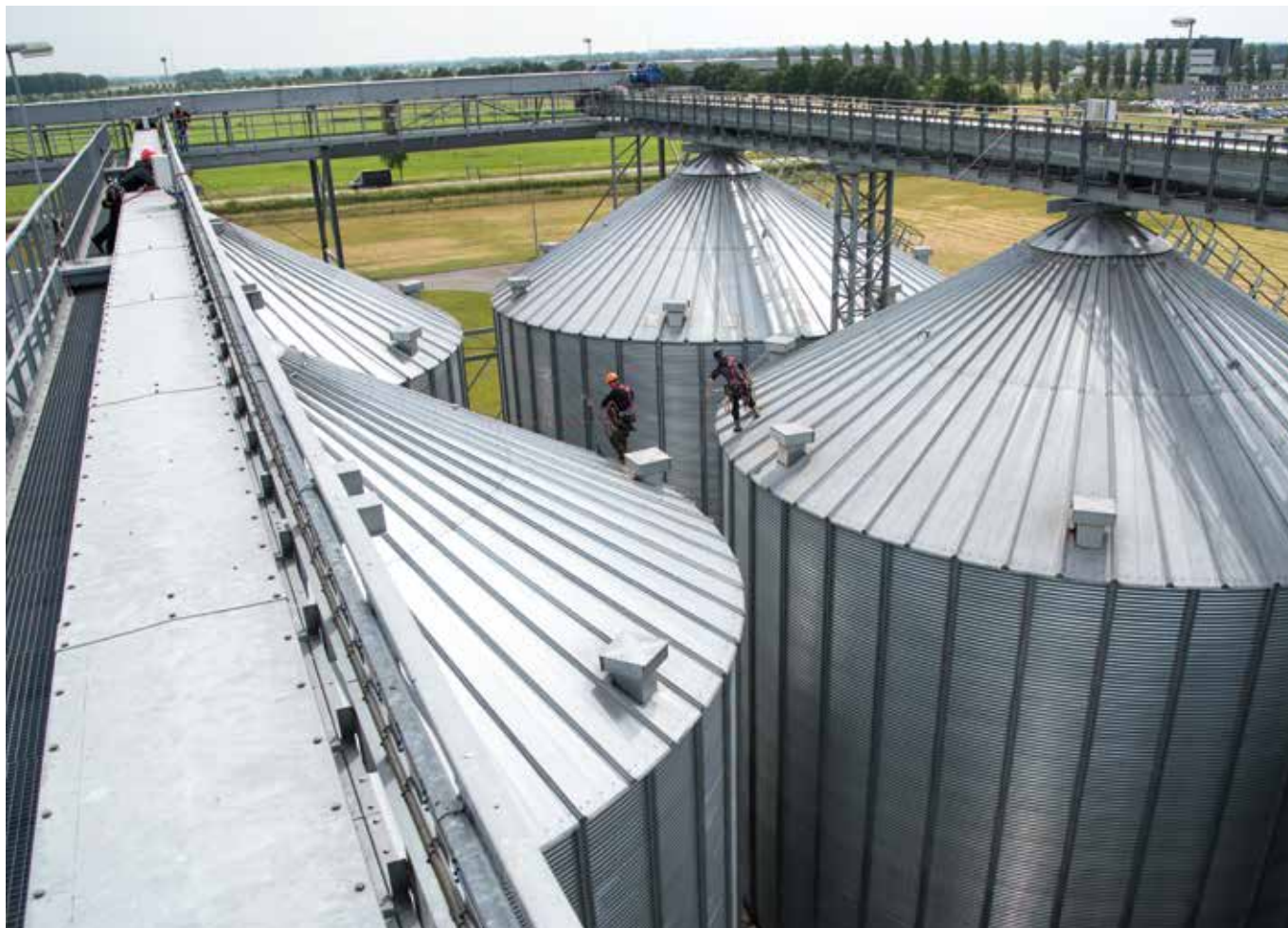
Maintenance operations on the silos of Voergroep Zuid, producer of animal feeds. Operaciones de mantenimiento en los silos de Voergroep Zuid, productores de pienso para animales. Oss, The Netherlands (ph. Riky Felderer, courtesy of Unispect, © C.A.M.P.).
