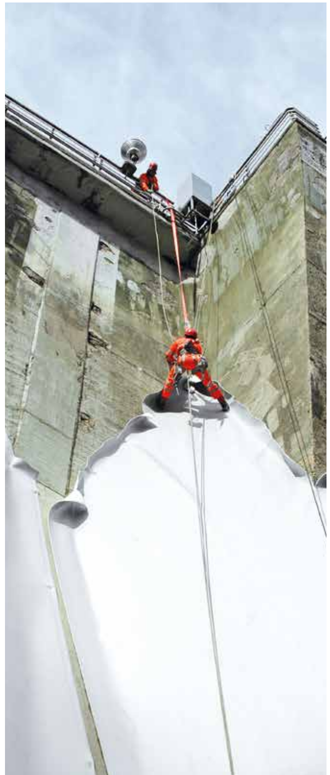
Mountain guide Pietro Guzza during waterproofing work on the Poglia dam. El guía de montaña Pietro Guzza, durante unos trabajos de impermeabilización en la presa de Poglia. Cedegolo, Italy (ph. Mauro Casalini, © C.A.M.P.).
