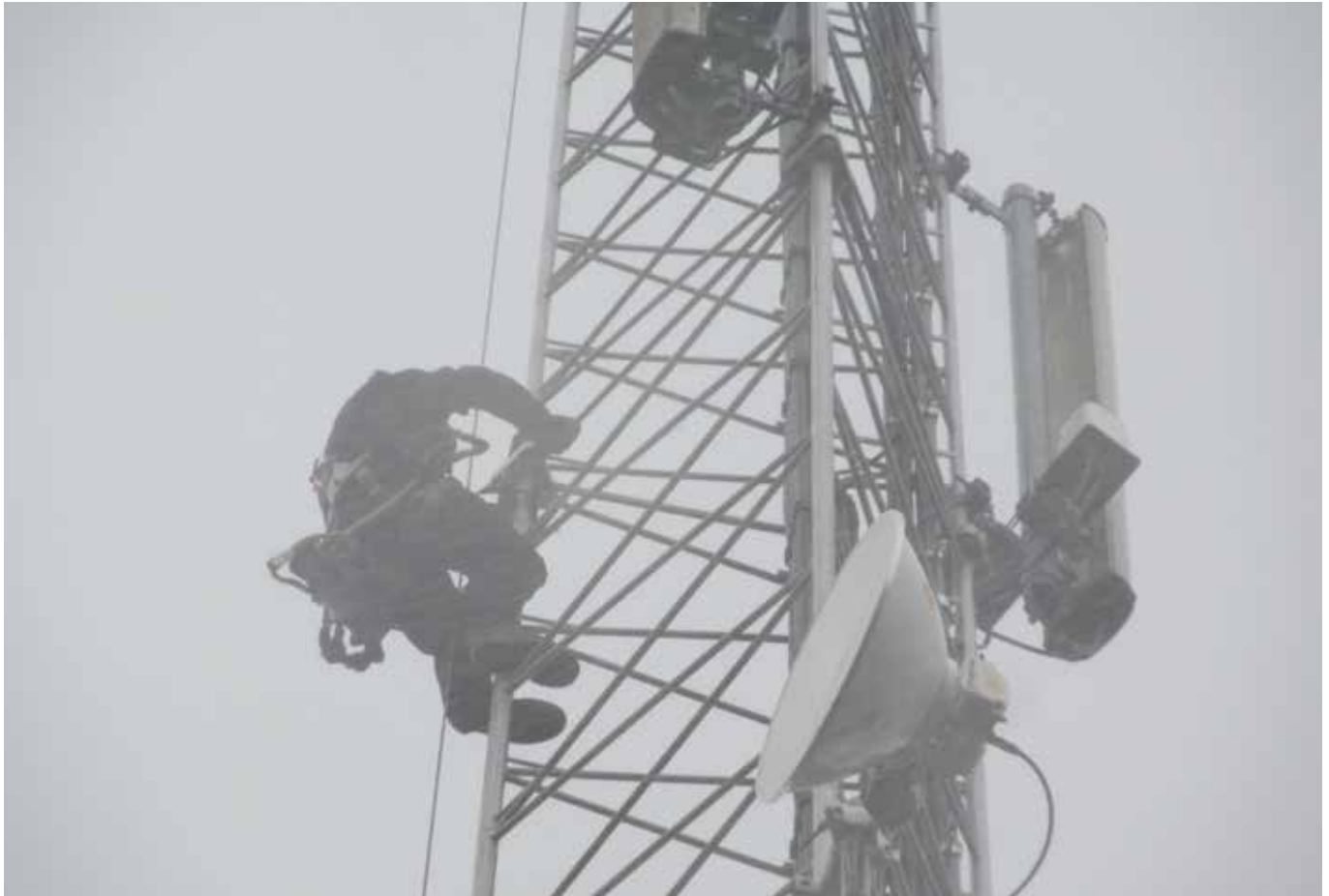
Inspection of permanent fall protection systems on a Vodafone mast. Inspección de los sistemas anti-caídas permanentes en una torre de Vodafone. Sint-Oedenrode, The Netherlands (ph. Raoul Stumpf, courtesy of Unispect, © C.A.M.P.).
