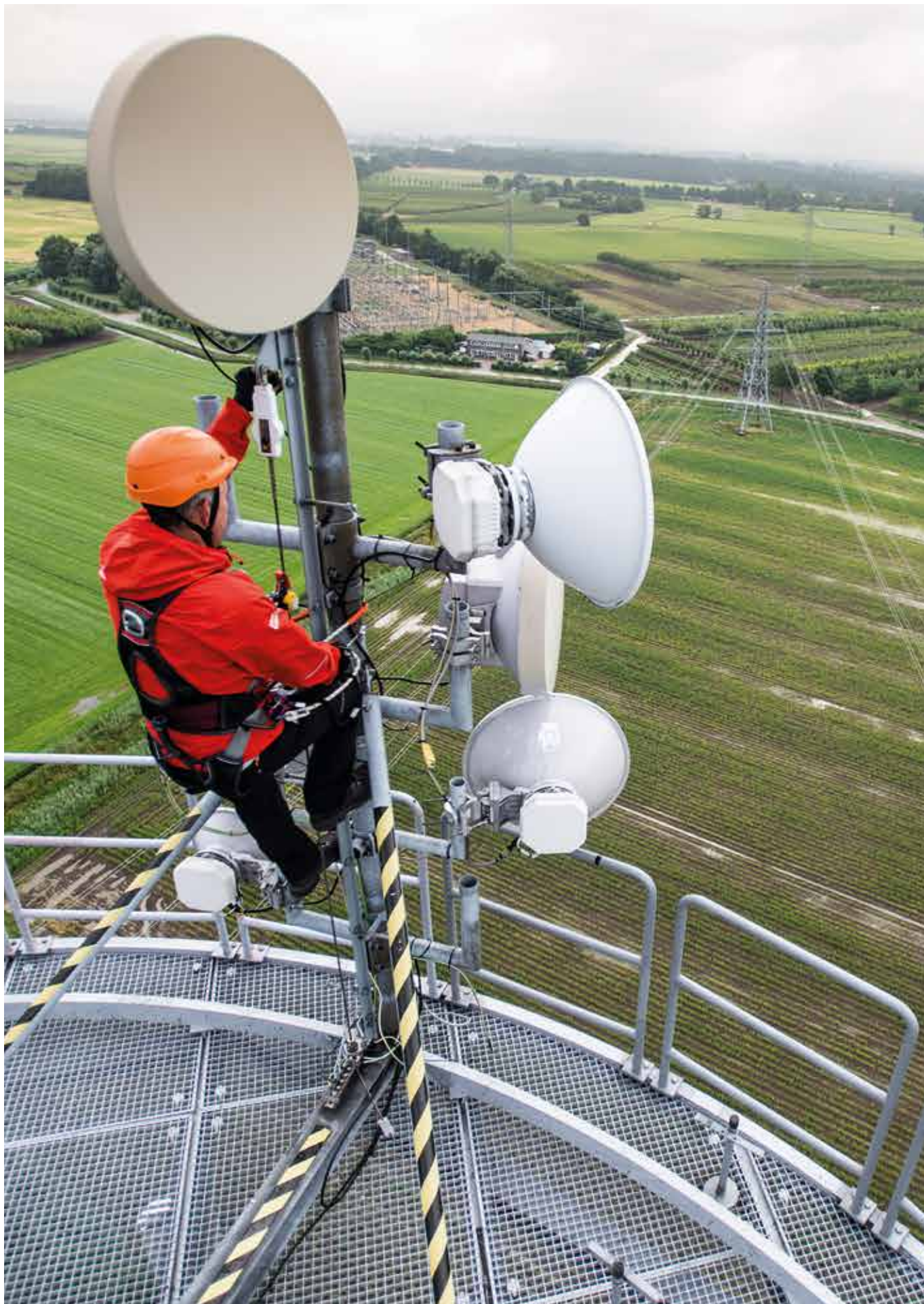
Inspection of permanent fall protection systems on a shared NOVEC mast. Inspección de los sistemas de protección permanente anti-caídas en una torre NOVEC. Dodewaard, The Netherlands (ph. Riky Felderer, courtesy of Unispect, © C.A.M.P.).
