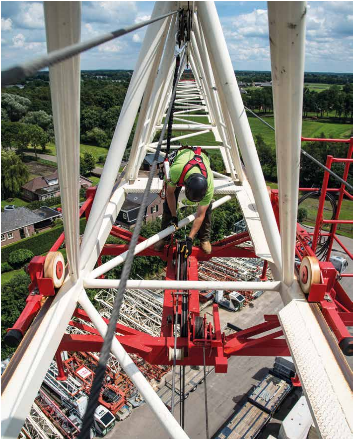
Inspection on a tower crane at Stravers Torenkranken factory. Inspección de una torre de grúa en la factoría Stravers Torenkranken. Veghel, The Netherlands (ph. Riky Felderer, courtesy of Heightinfra, © C.A.M.P.).
