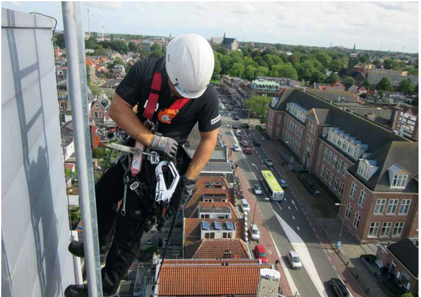
Inspection of fall protection systems on a water tower. Inspección de los sistemas de protección permanente anti-caídas en un depósito de agua. Alkmaar, The Netherlands (ph. Raoul Stumpf, courtesy of Uninspect, © C.A.M.P.).
