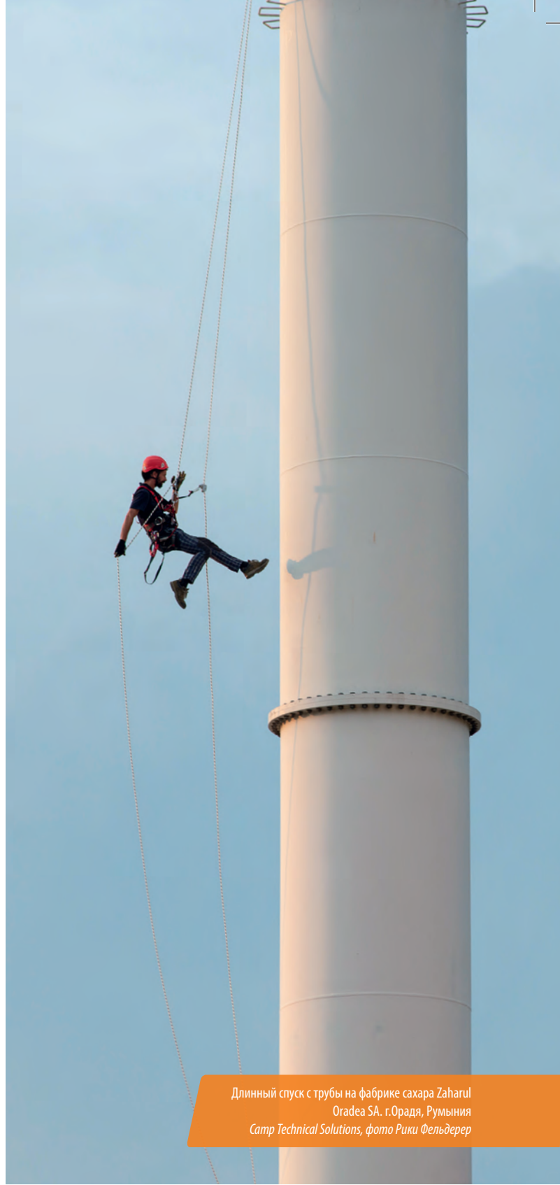
Рис. 10 Если пользователь находится в безопорном положении и ему необходимо осуществлять подъемы на короткие расстояния, мы рекомендуем использовать спусковое устройство, которое также позволяет подняться в сочетании с ручным зажимом и петлей под ногу. Такая комбинация оборудования позволяет легко и быстро переходить от спуска к подъему и наоборот.
